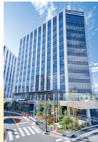
大和ハウス 東関東支社 新社屋 令和5年11月撮影
